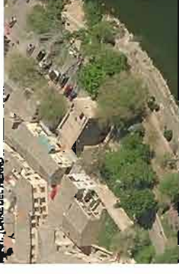
82-01. MERRALLAS DE LA TORRE DEL HIERRO 04. TORRE DEL HIERRO
