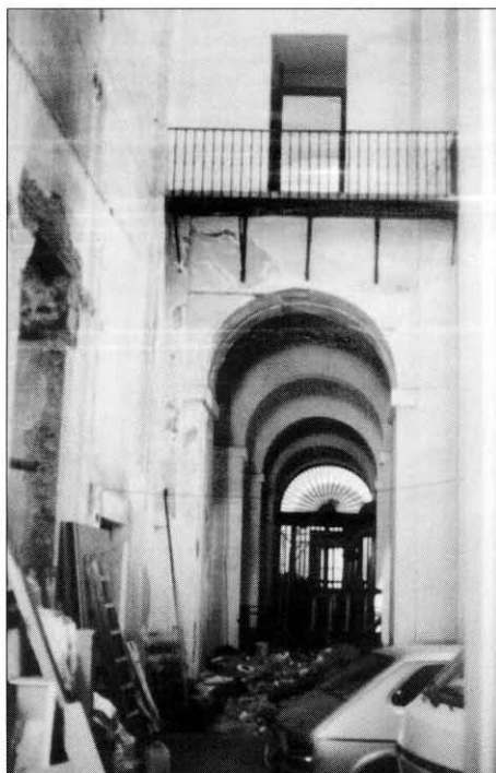
Lámina 9: Vista de la nave de la epístola desde el crucero, antes de la rehabilitación.
