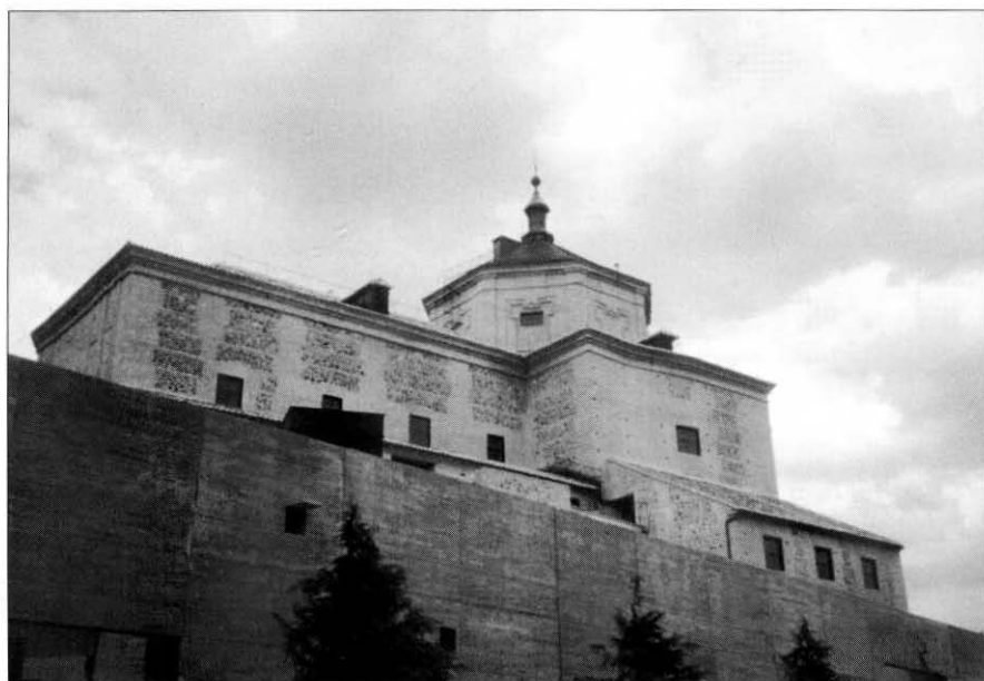
Lámina 2: Flanco suroccidental rehabilitado y edificio del archivo municipal.
