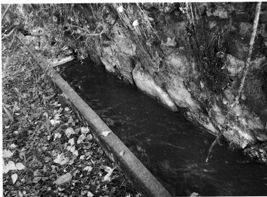
Vista parcial del interior de la barcaza, relleno de hojarasca, con vista parcial de la borda y del canal.
