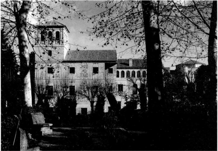
Fig. 1.- Vista de la fachada sur del Monasterio de Montesión.
