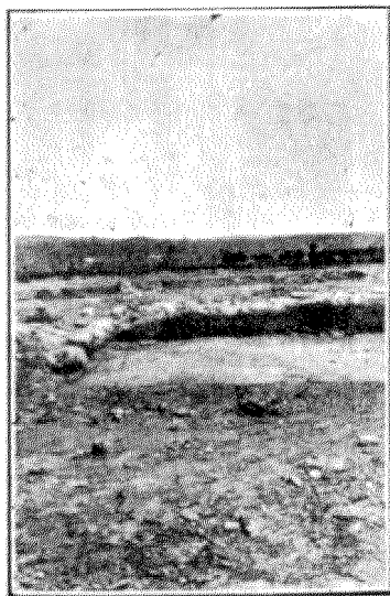
Restos de la construcción
