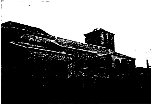
4.—Iglesia de La Estrella: Fachada Norte
