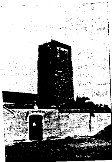
Fig. 12.—Bóveda de crucería del ábside.—Fig. 13. Columna adosada y doble arranque de los nervios de la bóveda. Se aprecia la misma técnica constructiva en esta iglesia que en la posterior de Aldeanueva (véase Fig. 5).—Fig. 14. La «Torre del cura», que se levanta en la huerta aneja a la casa rectoral.—(Fotos: Flores Hita).
