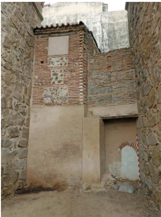
Fig. 12. Vista de la alhóndiga bajo el arco de la torre albarrana y salida de la Calleja de la Barbacana (Autores).
