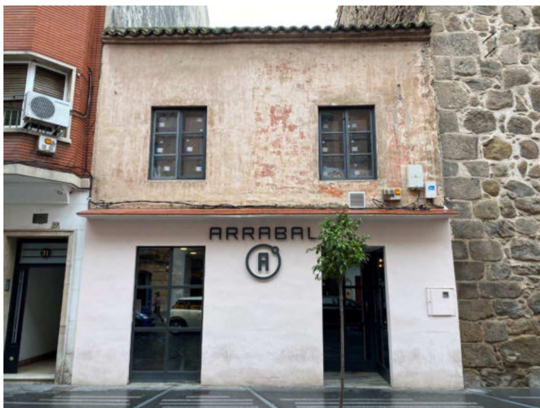
Fig. 1. Vista actual de la fachada conservada de la alhóndiga en la calle Corredera del Cristo. Año 2020 (Autores).
