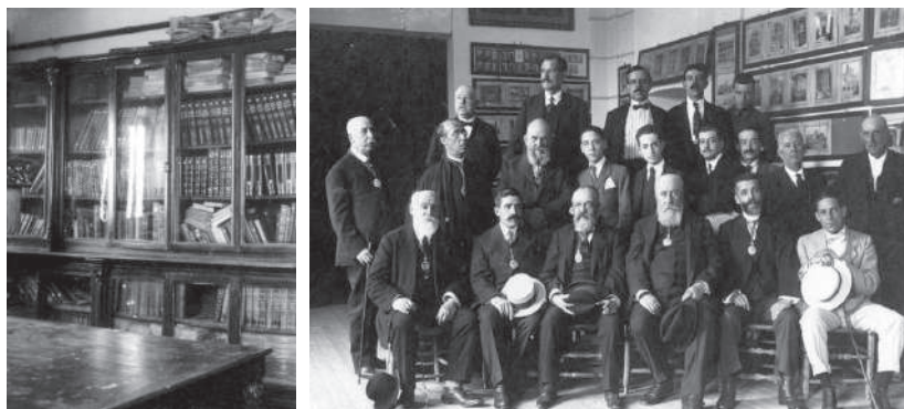
Antiguo despacho del director (sobre 1920). Las librerías están realizadas en la Escuela con diseño de Arturo Mérida. Puede apreciarse la lámpara de J. Pascual. A la derecha, fotografía con algunos de los Académicos fundadores.
