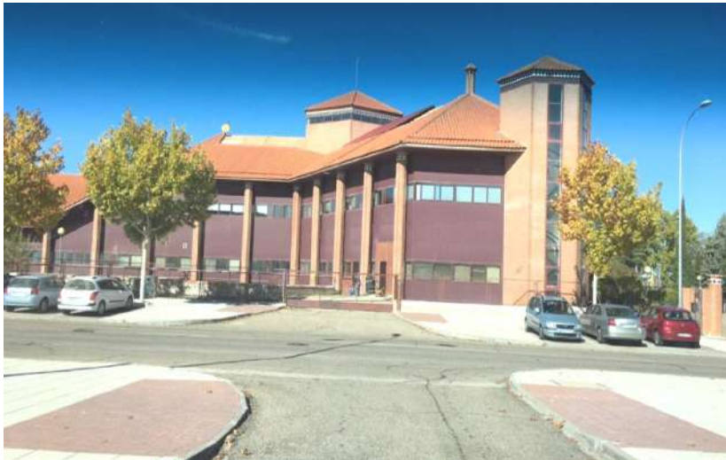
Polígono Industrial. Centro Tecnológico de la Arcilla.
