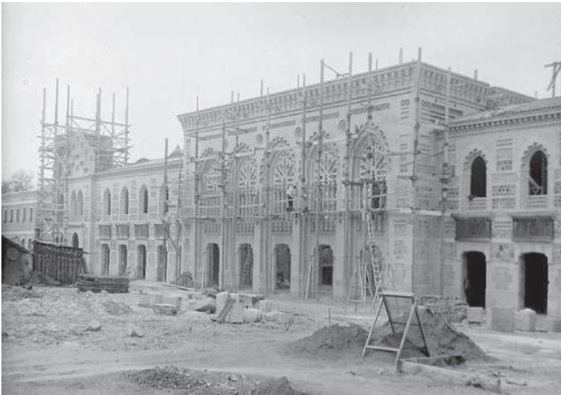
Estación de ferrocarril en construcción.
