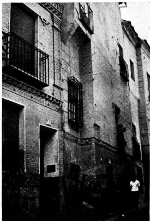
LÁMINA XVI.—Calles muertas de Toledo.—Antigua salida del callejón del Abogado, entre los núms. 7 y 9 de la bajada a los Carmelitas Descalzos, absorbido por una colindante, quizá por tener un cobertizo sobre él.
