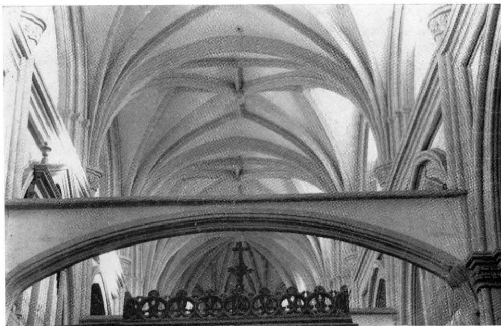
Bóvedas de la nave central
