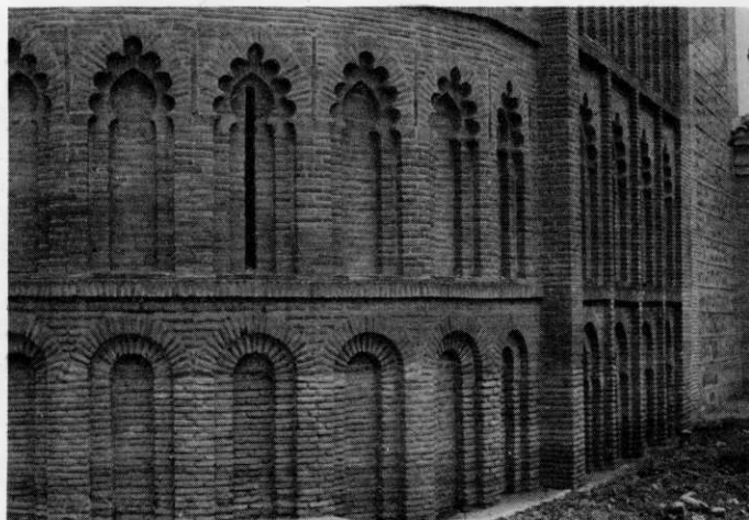
13. CRISTO DE LA VEGA. Exterior de la parte inferior del ábside.
