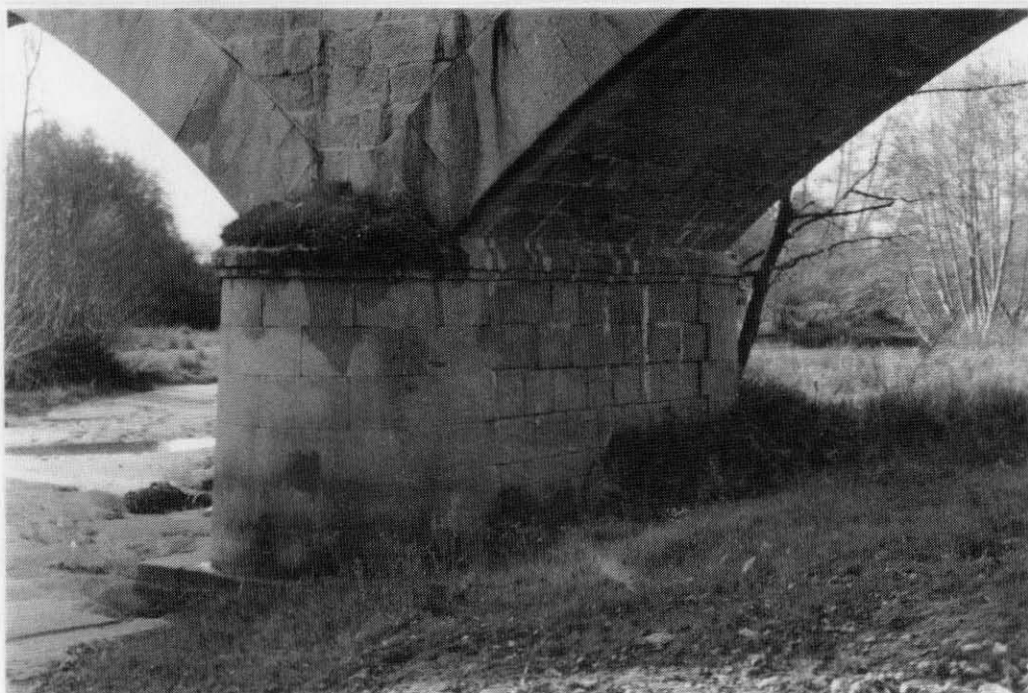
Escalona (Toledo). Puente sobre el río Alberche. c. 1992. Tajamar y cepa.
