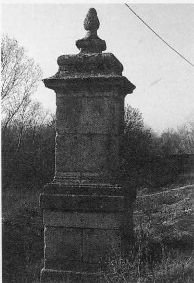
Pilar de entrada al puente de La Puebla
