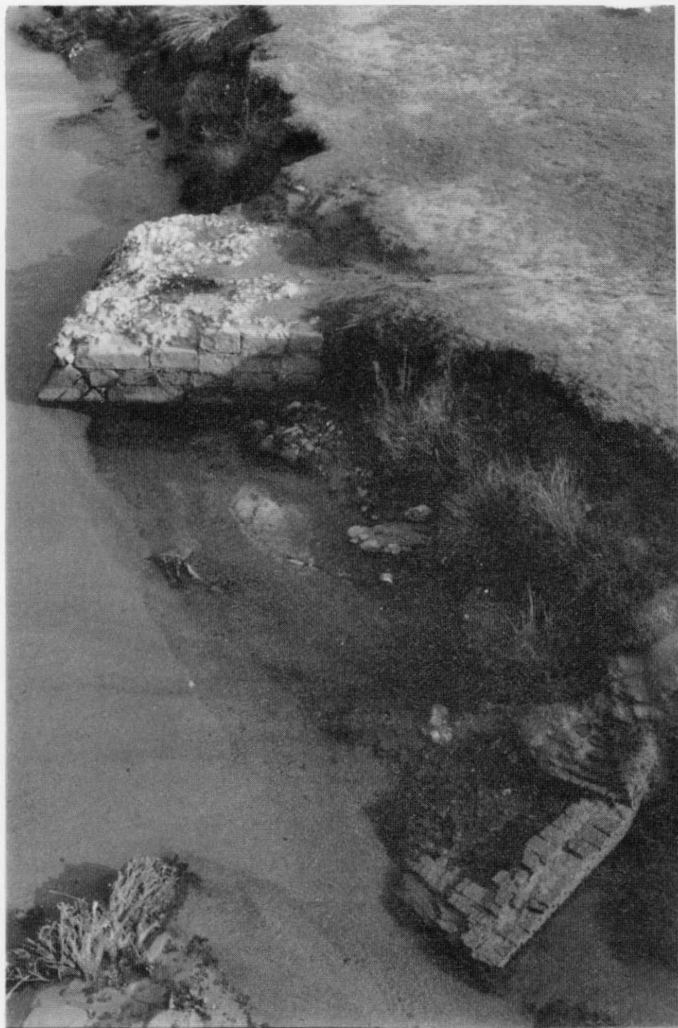
Escalona (Toledo). Puente sobre el río Alberche. c. 1992. ¿Restos de una construcción anterior?
