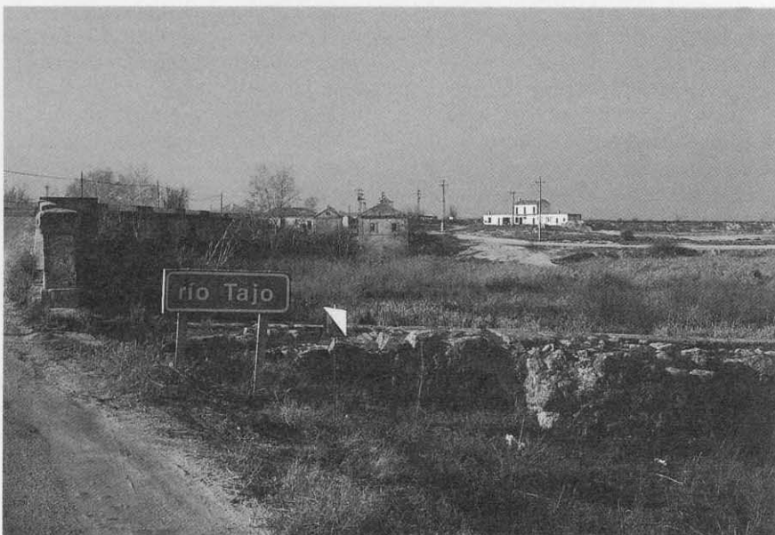
Entrada del puente desde La Puebla de Montalbán; a la izquierda, el pilón.
