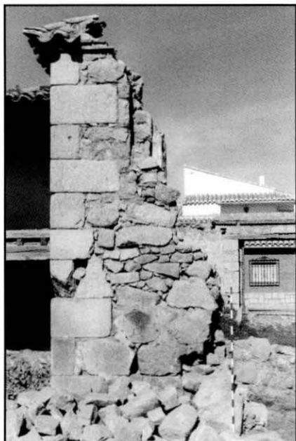
Lámina 8.—Restos del paramento sur de la torre del cuerpo adosado.
