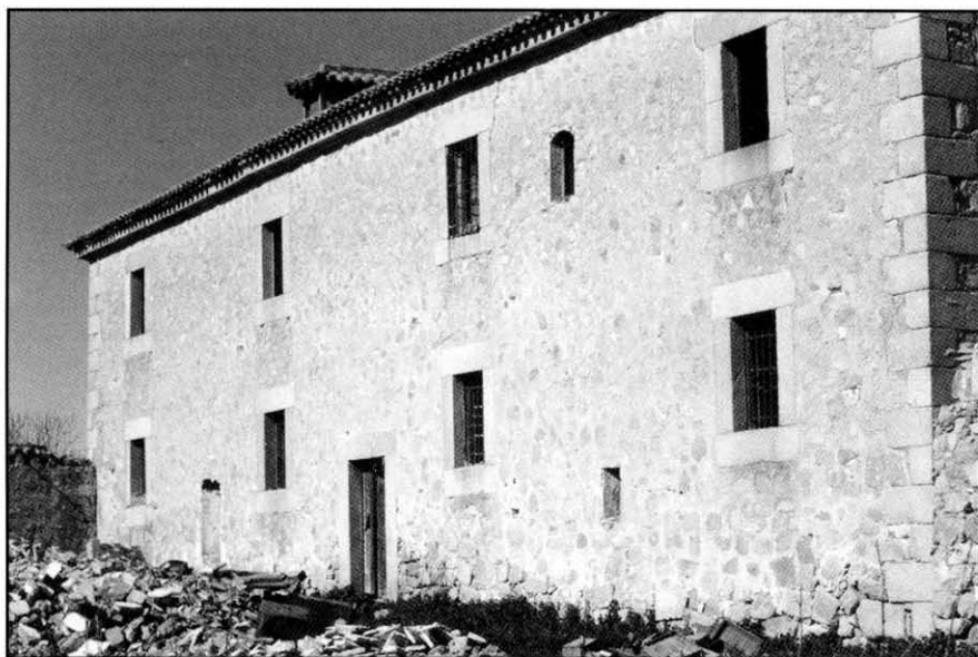
Lámina 3.—Vista de la fachada sur.
