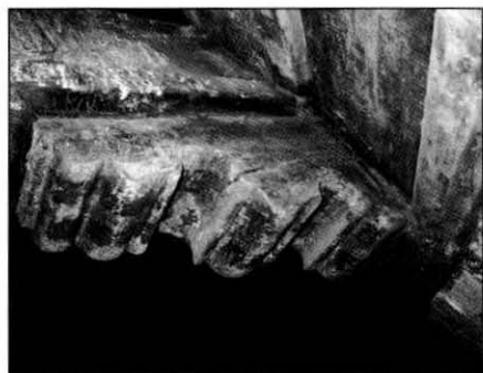
Fig. 54: Can de lóbulos en la armadura de limas en el Lado a (crujía norte) del piso superior.
