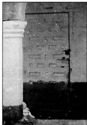
Fig. 58: Puerta en la galería del Lado B en la fotografía del Conde de Cedillo (1919).
