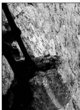
Fig. 64: Ménsula derecha de la reja a en la fachada norte.
