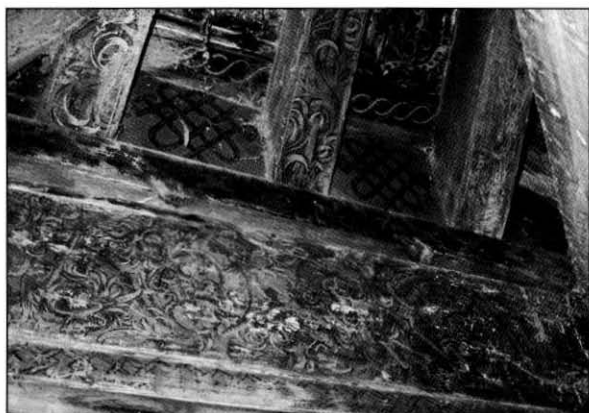
Fig. 56: Alicer con decoración floral, almarbate con decoración de entrelazo geométrico y tablas con decoración tipo cordón en la armadura de limas del Lado a.
