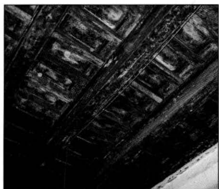
Fig. 44: Alfارje del Lado b (crujía este) en la planta baja.
