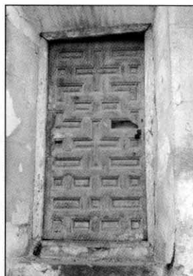
Fig. 60: Cara externa de una de las puertas de la fachada norte.
