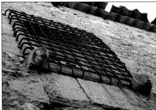
Fig. 62: Reja a, en la fachada norte.
