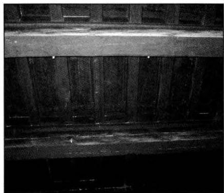
Fig. 42: Alfارje en el Lado a (crujía norte) de la planta baja.
