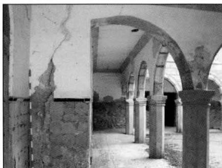
Fig. 21: Arco B-C y pilar encastrado en el muro, galería del Lado c (fotografía de Soledad Sánchez-Chiquito de la Rosa, op. cit., p. 66, Fig. 36).
