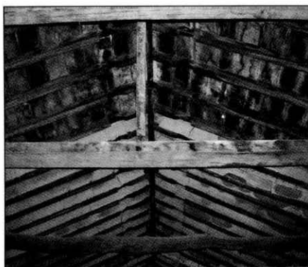
Fig. 51: Armadura de par y nudillo en el Lado b (crujía este) del piso superior (fotografía de Soledad Sánchez-Chiquito de la Rosa, op. cit., p. 73, Fig. 47).
