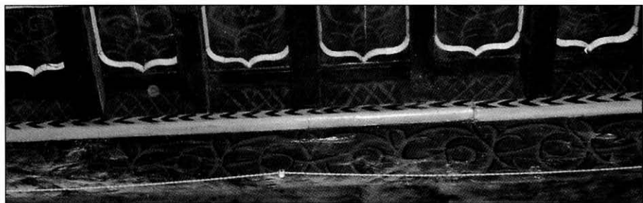
Fig. 46: Decoración geométrica en las caras verticales de las jácenas, alfarje del Lado b (crujía este) en la planta baja.
