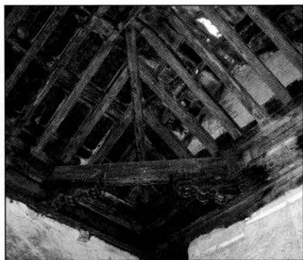
Fig. 53: Armadura de limas, ángulo: lima, pares menores, tirante oblicuo sobre canes.
