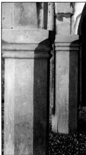
Fig. 11: Pilares octogonales (estado actual).
