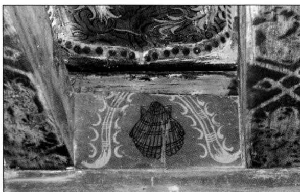
Fig. 49: Venera de Santiago, jácena del alfarje sobre la escalera.
