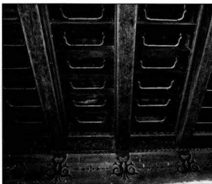
Fig. 43: Alfارje del Lado b (crujía este) en la planta baja.
