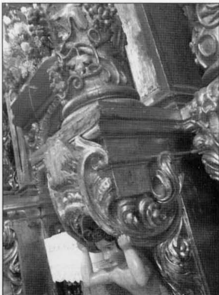
Daños en ménsula y basa.
