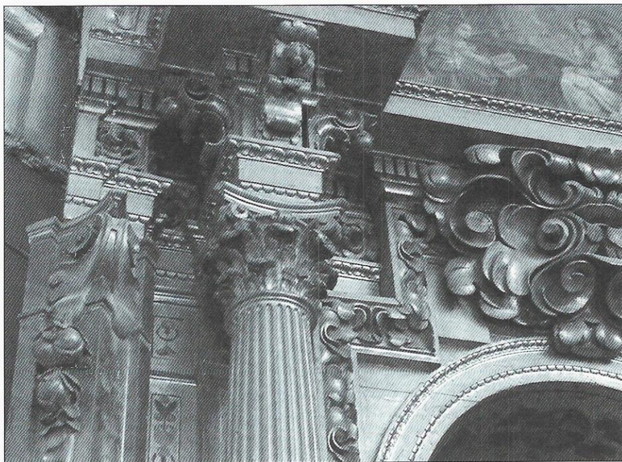
Fig. 2. Detalle del orden arquitectónico y ornamental.
