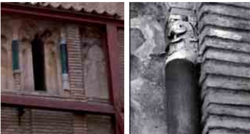
Iglesia de San Andrés – Andres 7. c Nordfassade – Portal. d Detail (Barroso – Morín 2007, 531 Nr. 283 fot. DAI).
