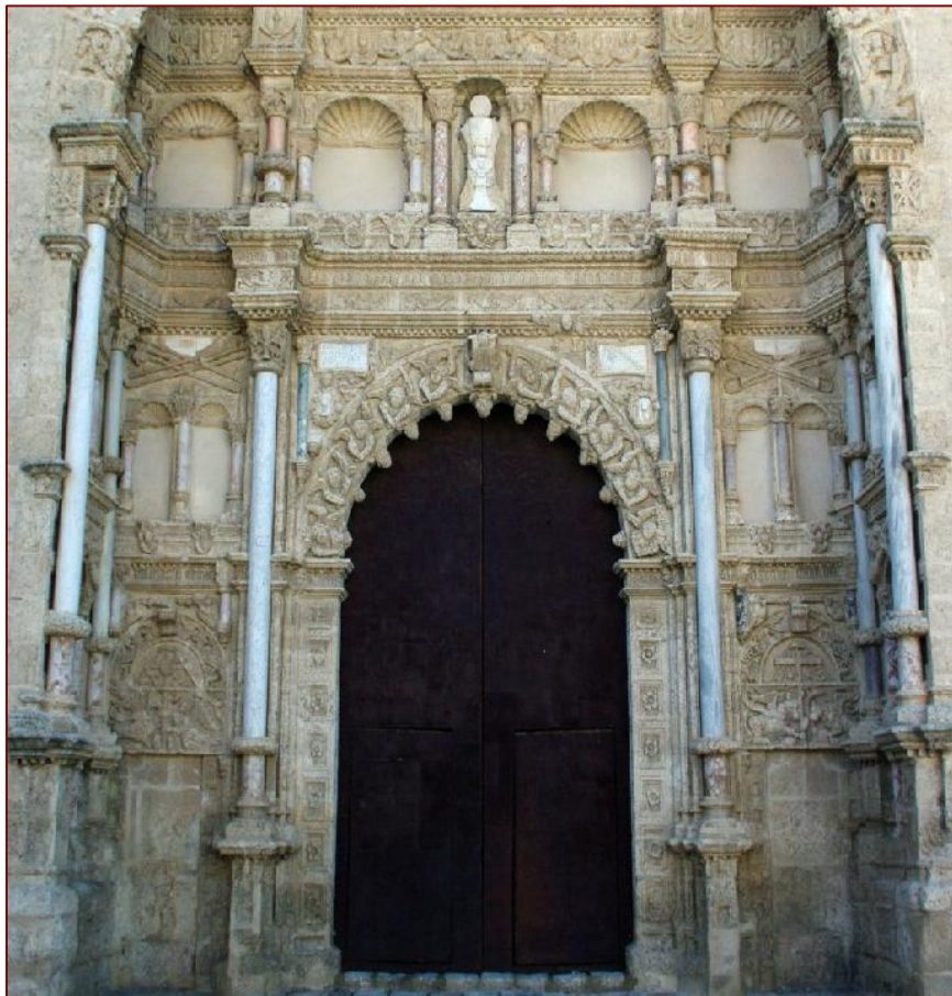
Fig. 8.- Cuerpo central de la portada de Poniente de la Colegiata, trazada como un arco de triunfo, Torrijos.
