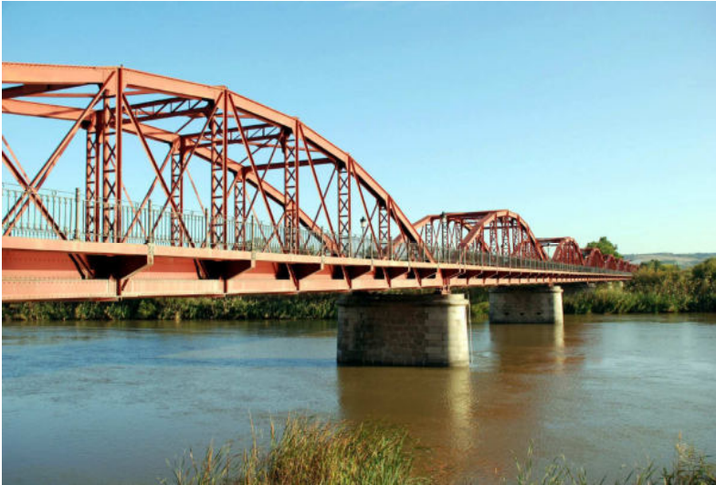
Fig. 8. Vista del Puente de Hierro (Foto: S. De la Llave).
