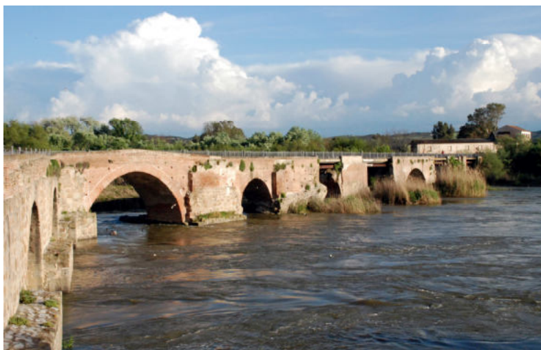
Fig. 7. Vista del Puente Viejo (Foto: S. De la Llave).
